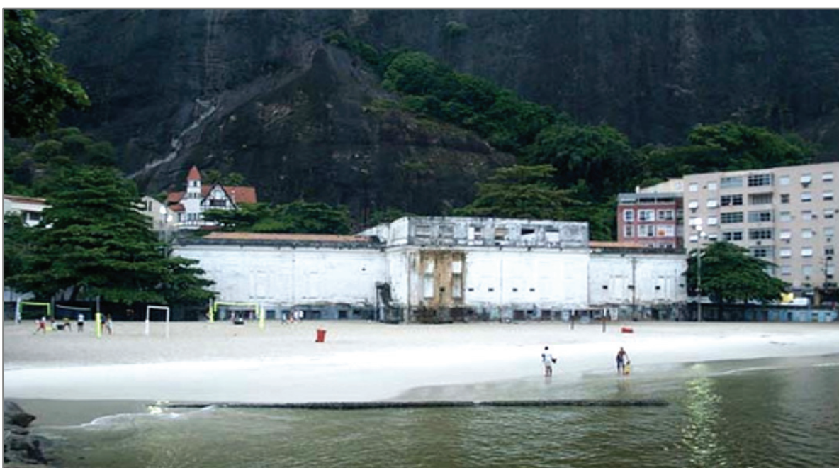
Figura 1 – Fachada antes da reforma
